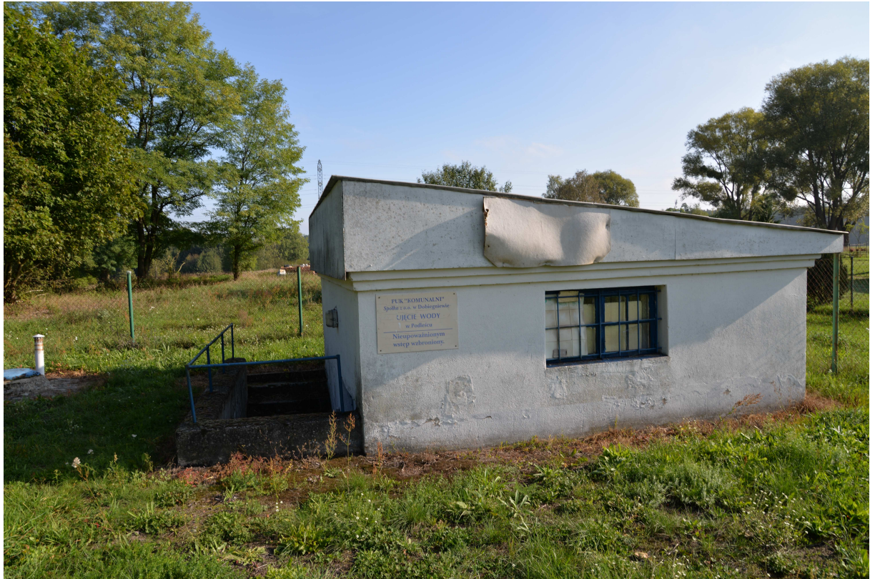
SUW Podlesiec - budynek stacji uzdatniania wody
